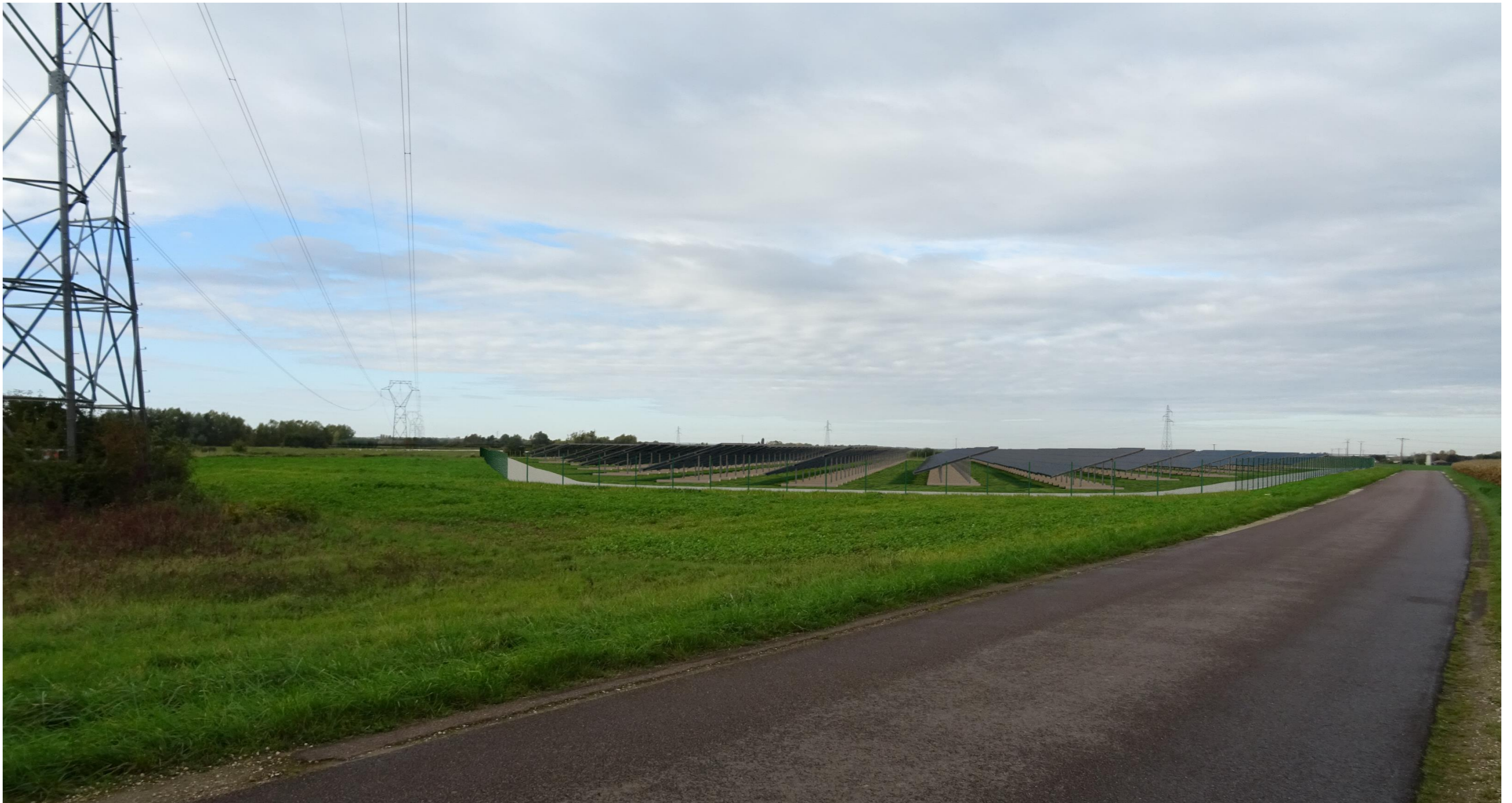
Vue depuis la route communale sur la partie au sol au nord-ouest de la centrale (avant mesures paysagères)
